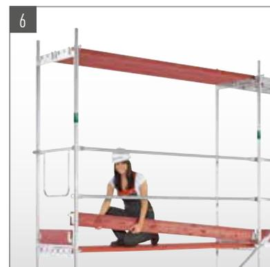
6 Après mise en place des cadres et planchers du prochain niveau, les diagonales, lisses et plinthes peuvent être accrochées.
