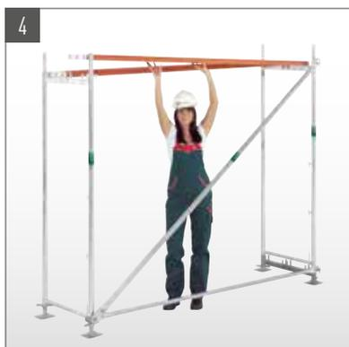
4 Pose du plancher, vérifier l'aplomb avec le niveau à bulle du cadre et le niveau de la lisse.
