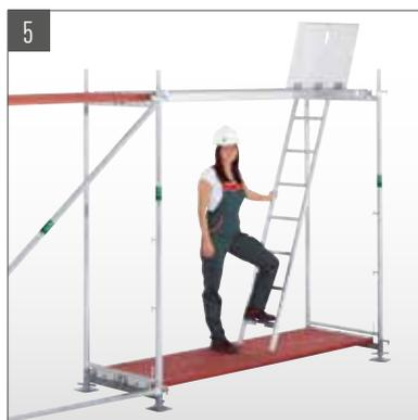
5 Mise en place d'un plancher bas afin de reposer l'échelle.
