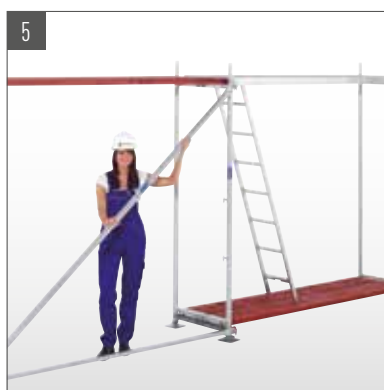
5 Montar la plataforma de paso.
