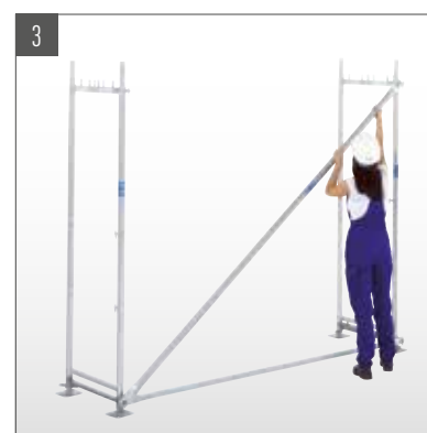
3 Montar las diagonales sobre los pasadores basculantes.
