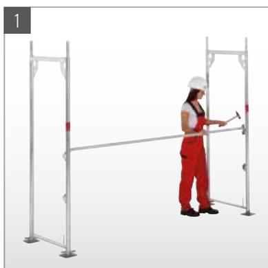
Positionnez les socles réglables, enfillez les cadres et raccordez les avec une lisse.
