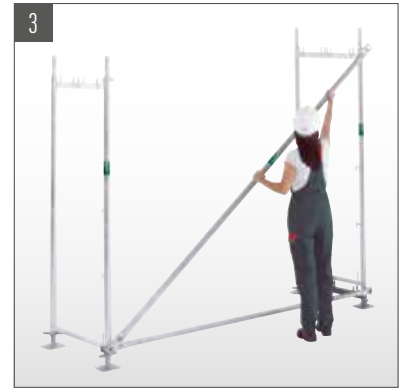
3 Montar la diagonal sobre el pasador basculante
