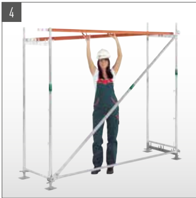
4 Montar las plataformas, verificar con un nivel la alineación vertical del bastidor vertical y la barandilla
