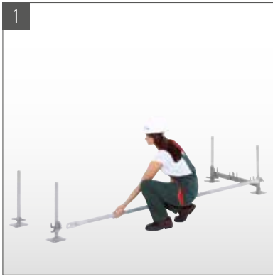
1 Situación de las bases regulables, diagonal horizontal sobre los pasadores, y el travesaño de inicio
