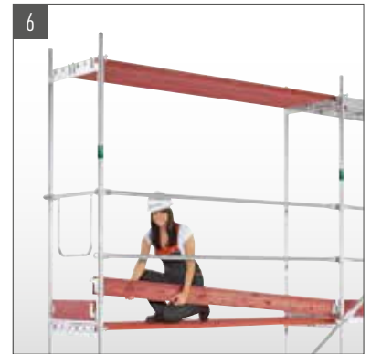
6 Montar los bastidores y plataformas del siguiente nivel y colocar las diagonales, barandilla y rodapiés
