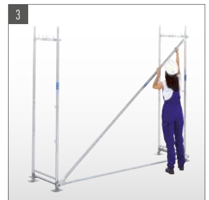
3 Diagonale über Kippstifte montieren.
