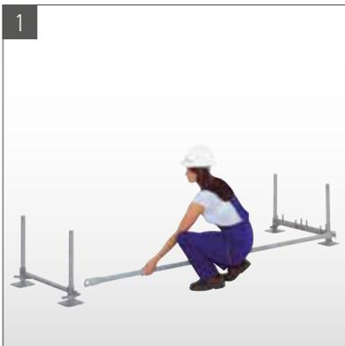
1 Fußspindeln aufstellen, Fußtraverse aufstecken, Rückengeländer einhängen (nur im Diagonalfeld).
