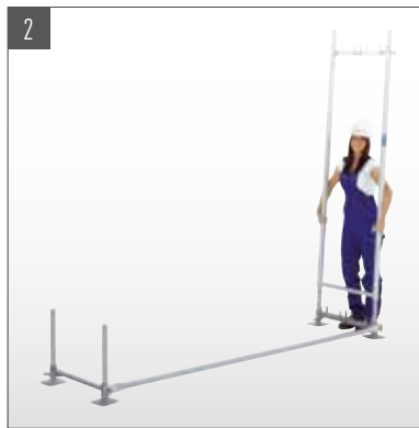
2 Vertikalrahmen aufstecken.
