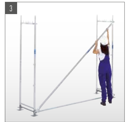
3 Diagonale über Kippstifte montieren.
