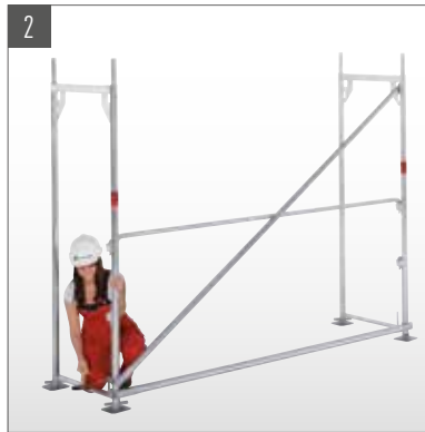
2 Vertikaldiagonale montieren, Horizontalstrebe einbauen (nur im Diagonalfeld).
