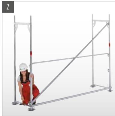
2 Vertikaldiagonale montieren, Horizontalstrebe einbauen (nur im Diagonalfeld).
