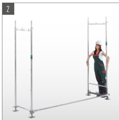
2 Vertikalrahmen aufstecken.
