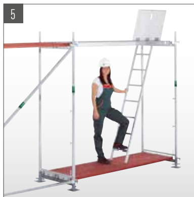
5 Innenliegenden Leitengang auflegen.
