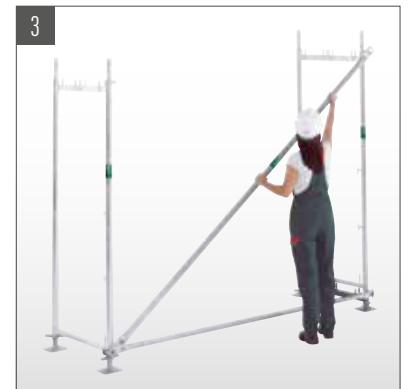
3 Diagonale über Kippstifte montieren.
