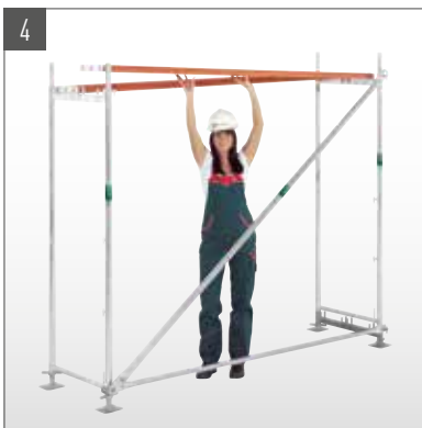
4 Beläge auflegen, Gerüstfeld mit Wasserwaage an Geländer und Rahmen lotrecht ausrichten.
