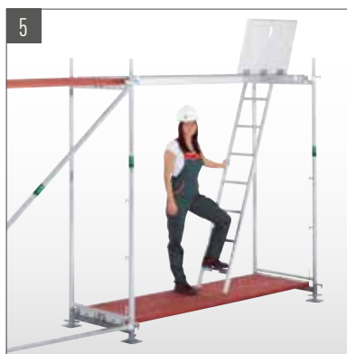
5 Innenliegenden Leitgang auflegen.
