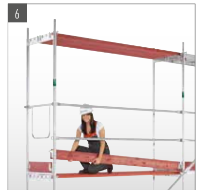
6 Vertikalrahmen und Beläge der nächsten Lage montieren, Diagonale, Geländer und Bordbretter einhängen.
