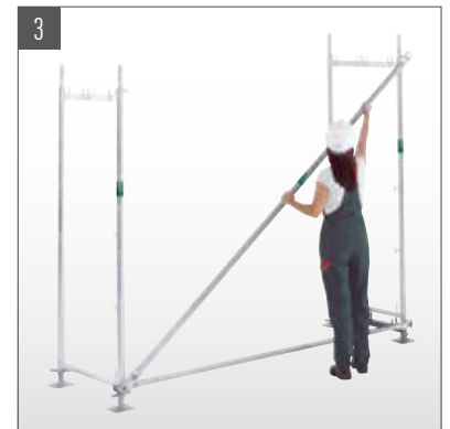
3 Diagonale über Kippstifte montieren.
